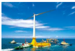
洋上風力発電施設の建設風景 出典：国立研究開発法人 新エネルギー・産業技術総合開発機構(NEDO)
